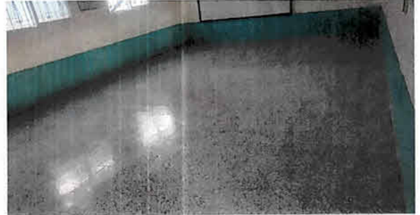
Foto 2: Sustitución de piso de granito
