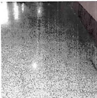
Foto 5: Sustitución de piso desanivelado que provoca posas de lluvia a corredores y aulas
